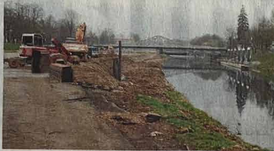
U DLOUHÉHO MOSTU v Českých Budějovicích se staví nové vývaziště pro malá plavidla. Foto: Deník/Edwin Otta
